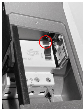
Figure 5 : Bouton de test RCD
